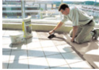
Verlegung von Feinsteinzeugfliesen 30 x 30 cm mit UNIFIX®-2K
